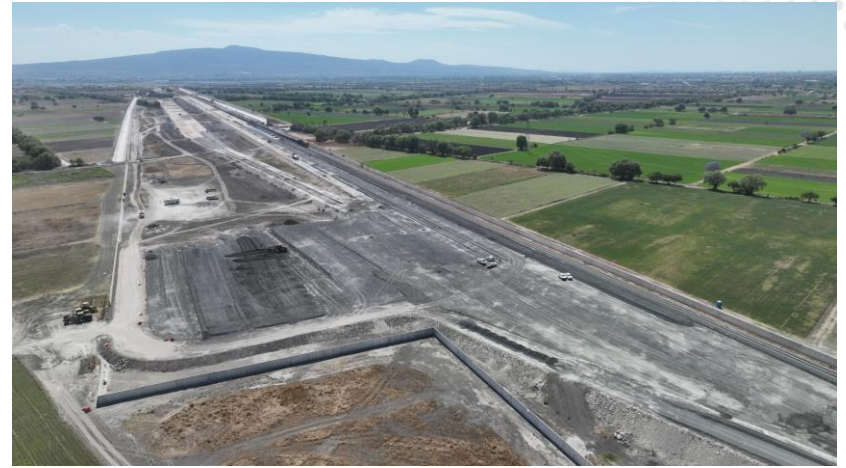
Terracerías Patio Operativo
