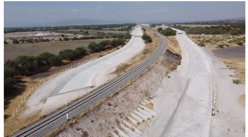
Canales Pluviales Norte y Sur
